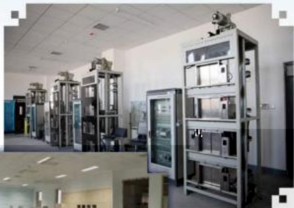
智能电梯安装调试维护训练场所
